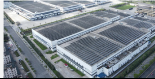
盐城东台科森 8MW 分布式光伏发电项目
