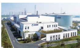
苏州工业园区餐厨及园林绿化垃圾处置项目
